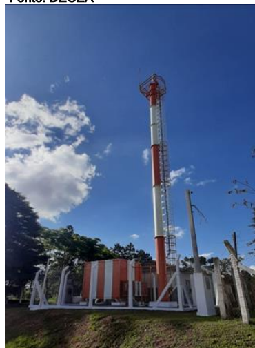
Estação DME São José (SC)
