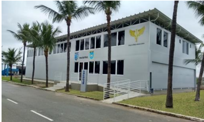
Prédio do NuCGTEC
