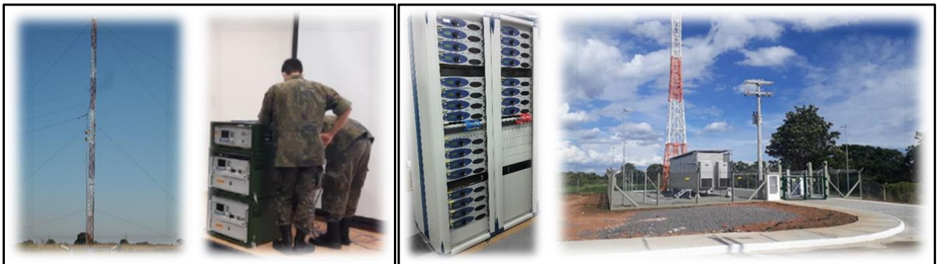
Antena e Equipamentos HF e VHF
