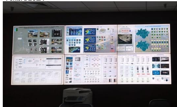
Painel de gerenciamento da Sala Técnica modernizada do CINDACTA IV
