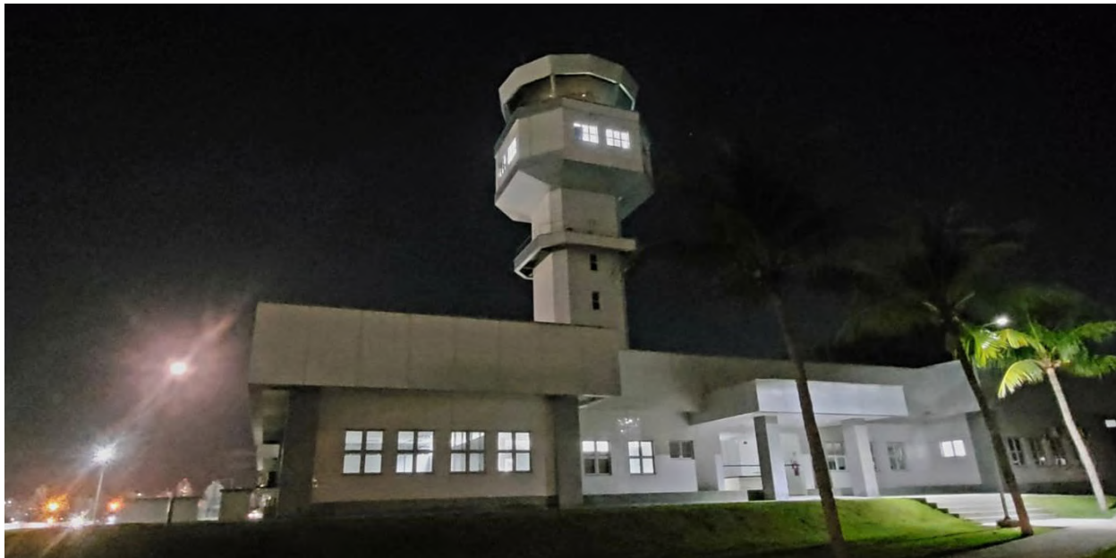
Edifício Técnico-Operacional (ETO) do APP Nordeste
